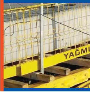
Ahşap Sıkıştırılmalı Dikme Wood Compressible Post Poste à Bois Compressible
